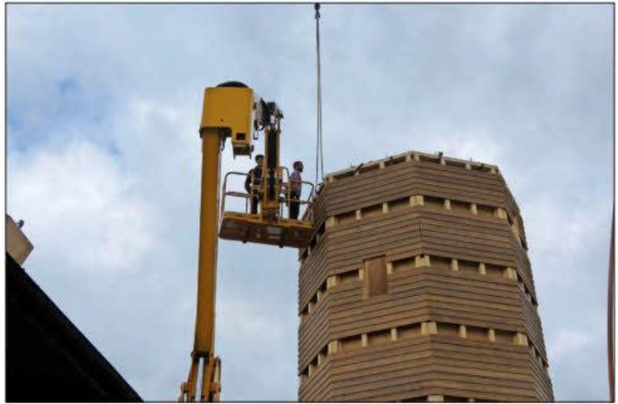
Der Leuchtturm bei der Demontage.
